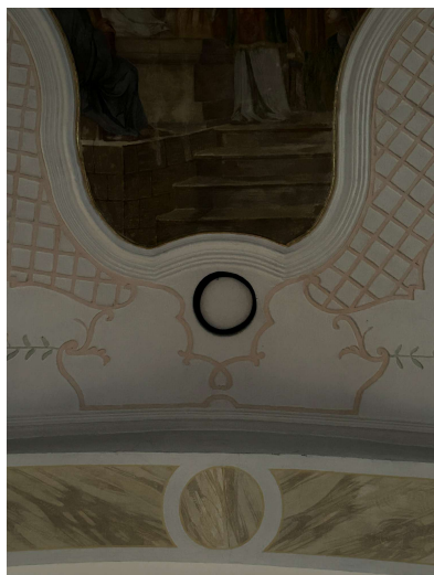
Foto E: Lüftungsloch im Hauptschiff.
