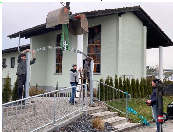
Montage des Eingangstores.
