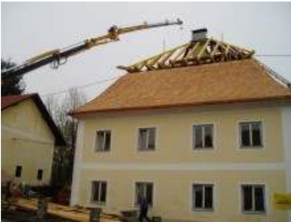
Die Dacheindeckung mit Holzschindeln wird durch Mitarbeiter der Firma Ortner aus Osttirol erledigt. Wir denken, dass diese Art der Dachgestaltung passend ist zur Form des Daches. Außerdem kommt dies durch die Bezuschussung durch das Bundesdenkmalamt für die Pfarre deutlich günstiger als jede andere Art von Dachdeckung. Außerplanmäßig musste der obere Teil des Dachstuhles erneuert werden.
