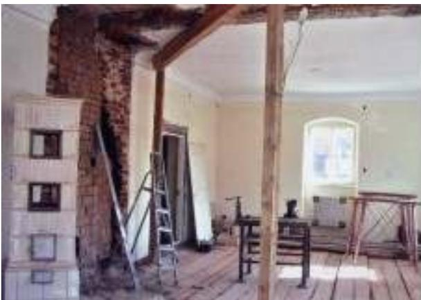
Die Abbrucharbeiten, Stemmen, Einsetzen des Trägers für die Zwischenwand im Oberge-
